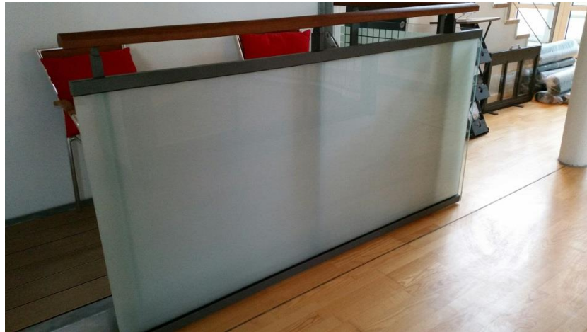
Rækværk med opallamineret glas i vandret ramme, håndliste er dog i lakeret aluminium.
