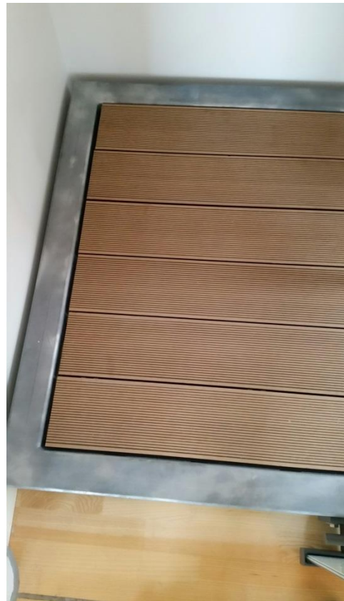
Gulvbelægning, ProDeck teak med skjult montage.
